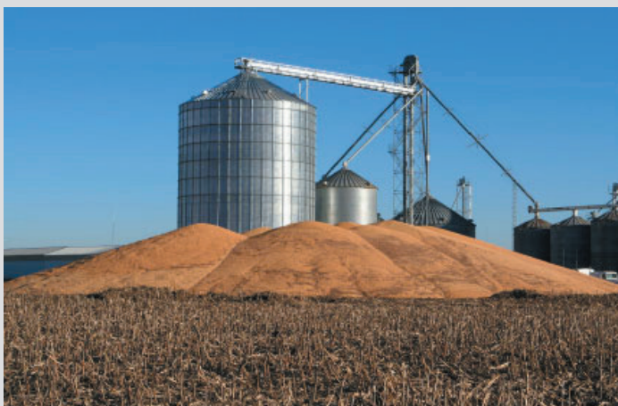
Silos de céréales avec élévateurs à godets.
